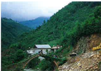
Yol yapımı (Giresun)
