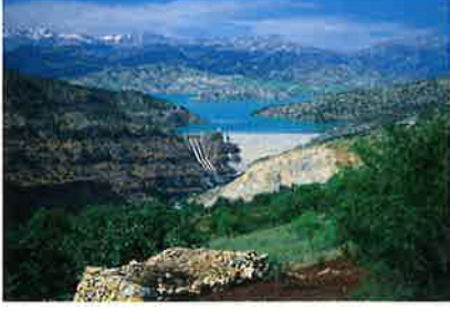
Baraj yapımı (Kahramanmaraş)
